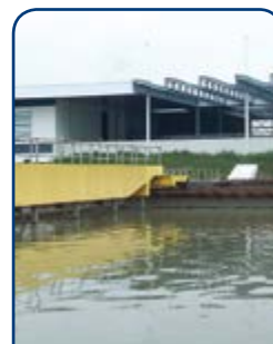
Usine de traitement, Lyon, France, grand diamètre
